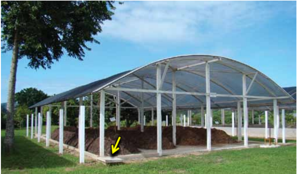
Figura 11. Local de compostagem com cobertura, piso impermeabilizado e local para coleta de chorumes nas extremidades da instalação (indicado com a seta amarela)
